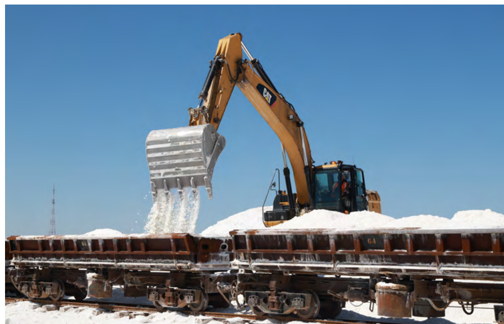
На фото: погрузка мирабилита в садочном бассейне
