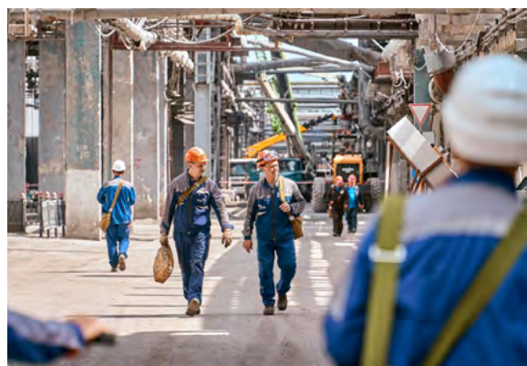
На фото: остановочный ремонт на стерлитамакской «Соде»
